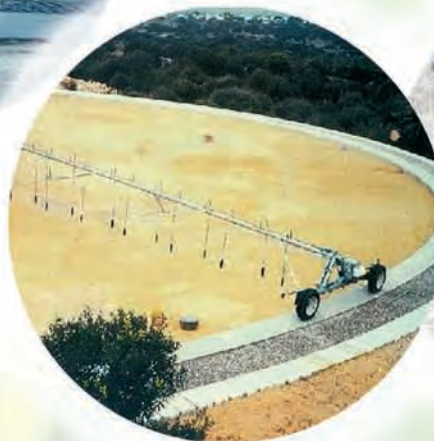
Pivot d'infiltration (Baléares) Sand filtration system (Balearic Islands)
